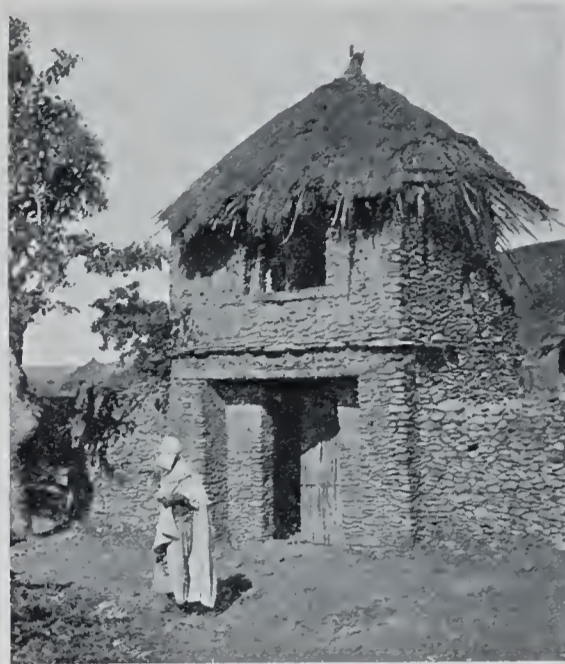
Abb. 95. Zweigeschossiges Torhaus mit Türnische. Aksum.
